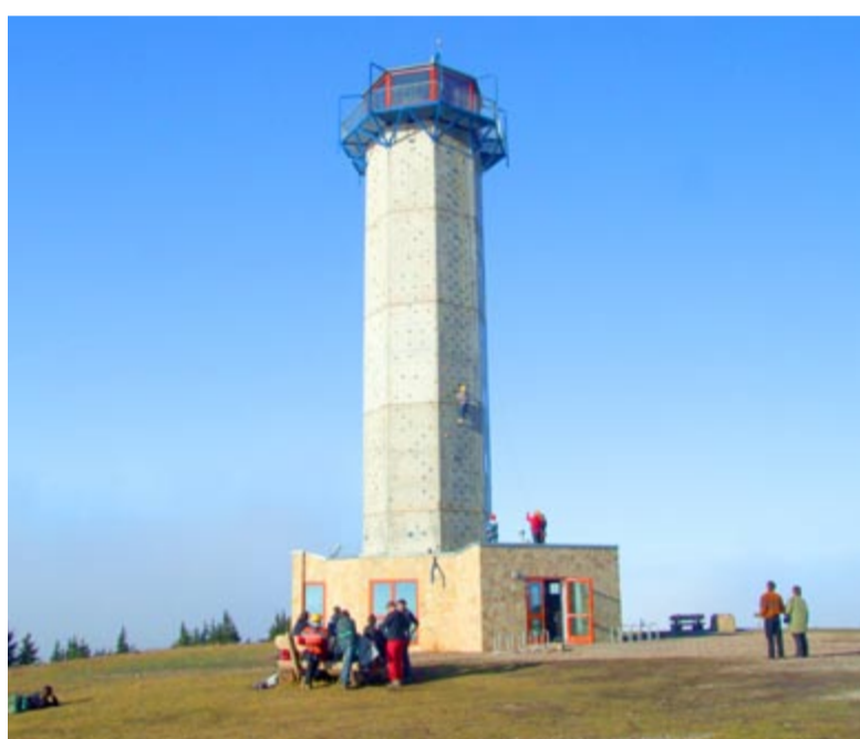
Der neue Schneekopf-Turm kann an drei Wänden über acht verschiedene Routen erklettert werden. Ausgebildete Trainer von „outdoor inn“ sorgen für die Sicherheit.
